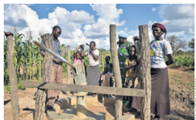
Reparatur eines Bohrlochs im Südsudan
