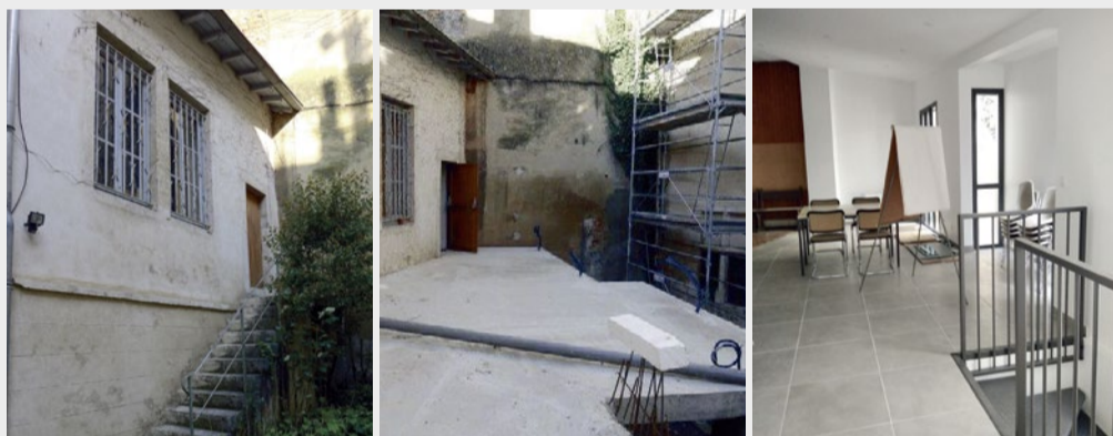
Eglise réformée de France, Bourgen-Bresse, Sanierung / Anbau, Vorher – Nachher
