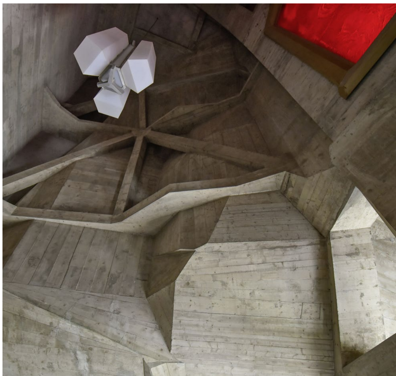
Innengewölbe des Goetheanums: Beton als Baumaterial bot völlig neue Gestaltungsmöglichkeiten.
