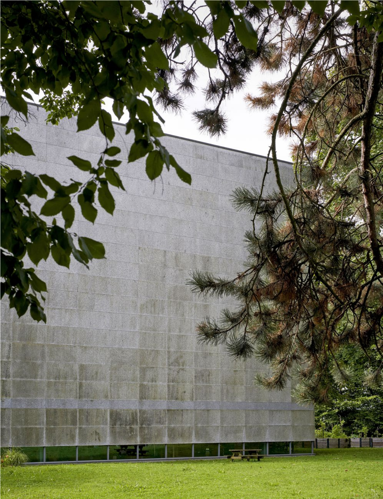
Vor einer ungewissen Zukunft: Die Andreaskirche im Quartier Sihlfeld in Zürich.
